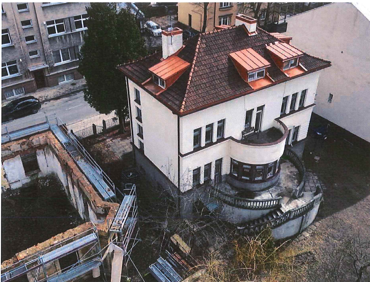
03 pav. Šiaurinio (kairiau) ir vakarinio (dešiniau) fasadų fotofiksacija
